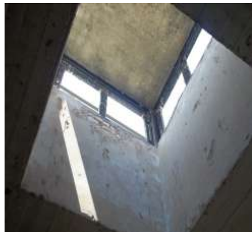
Фрагмент фонарных переплетов на кровле
