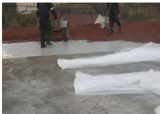
Фрагмент теплоизоляции кровли
