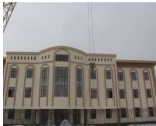
Общий вид здания поликлиники
