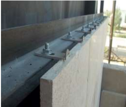
Система крепления вент. фасада
