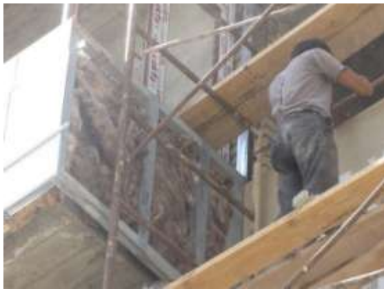
Фрагмент теплоизоляции балконов
