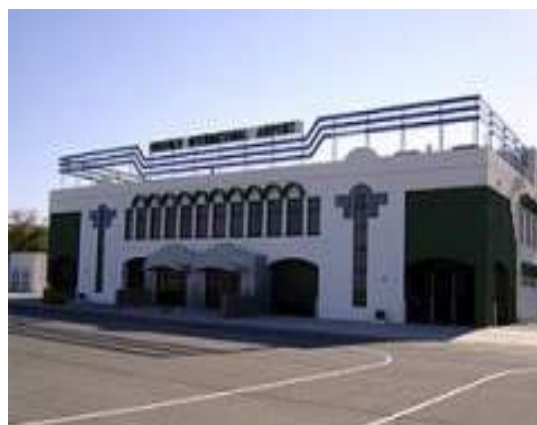
Общий вид здания прилета в г. Ургенч
