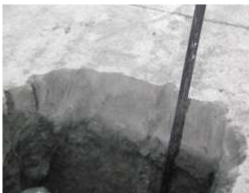
Фрагменты теплоизоляции чердачного перекрытия пенобетоном
