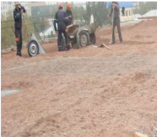
Фрагмент теплоизоляции кровли
