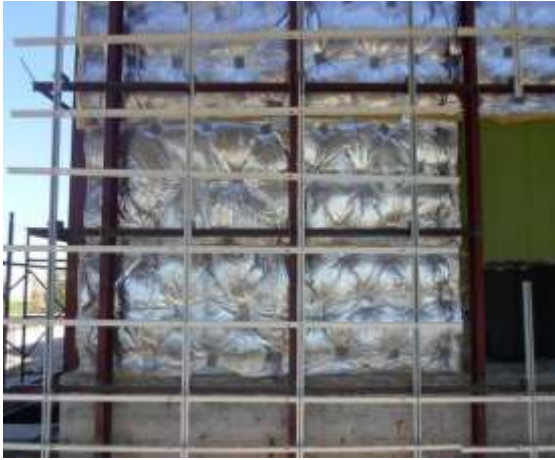
Фрагменты применения технологии «вентилируемого фасада»
