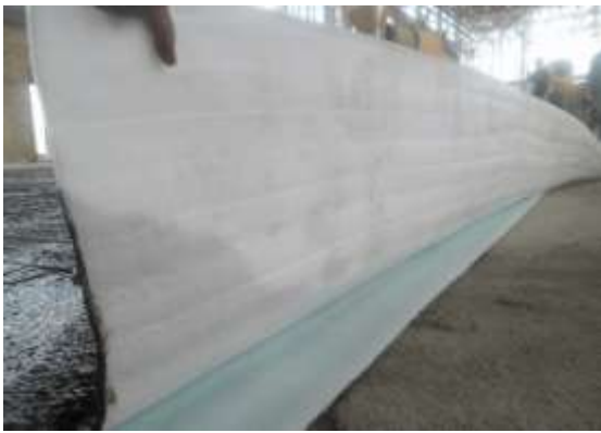
Теплоизоляция покрытия 1 этажа
