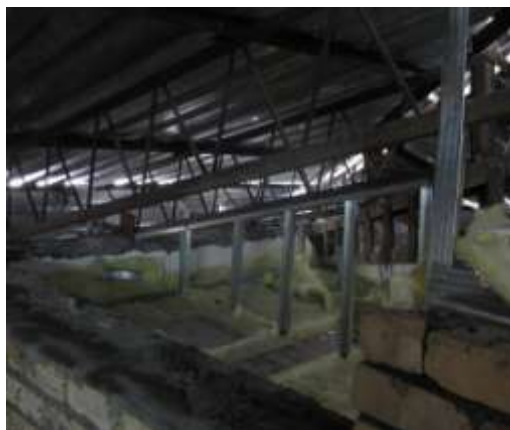
Теплоизоляция выходов и лифтовых шахт
