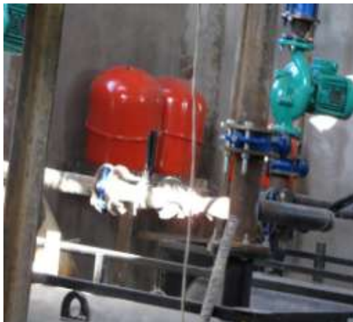
Система циркуляции теплоносителя отопления
