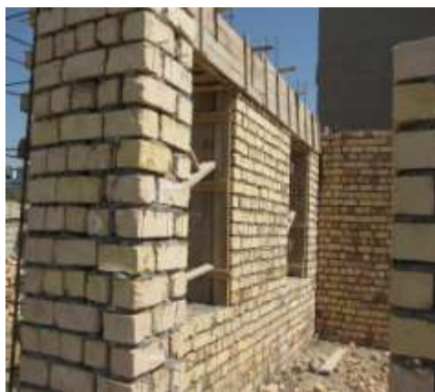
Фрагмент наружных стен в 2 кирпича
