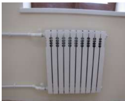
Установка отопительных радиаторов
