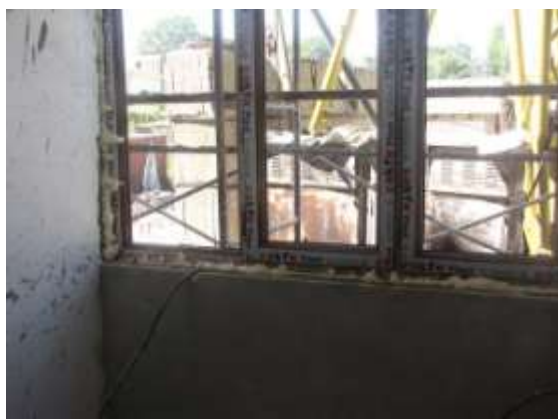
Фрагмент установки оконного блока
