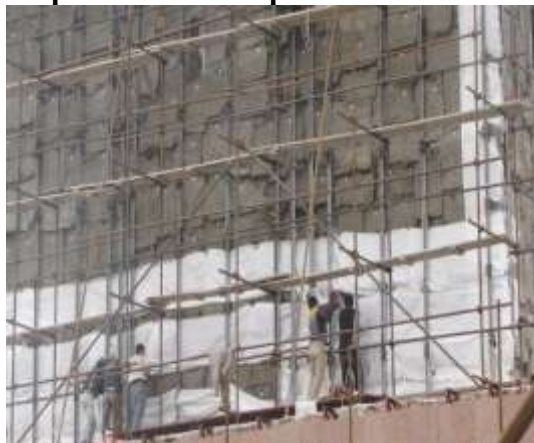
Фрагменты применения технологии «вентилируемого фасада»
