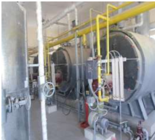
Котлы отопления с высоким КПД
