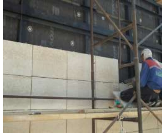
Фрагменты применения технологии вентилируемого фасада
