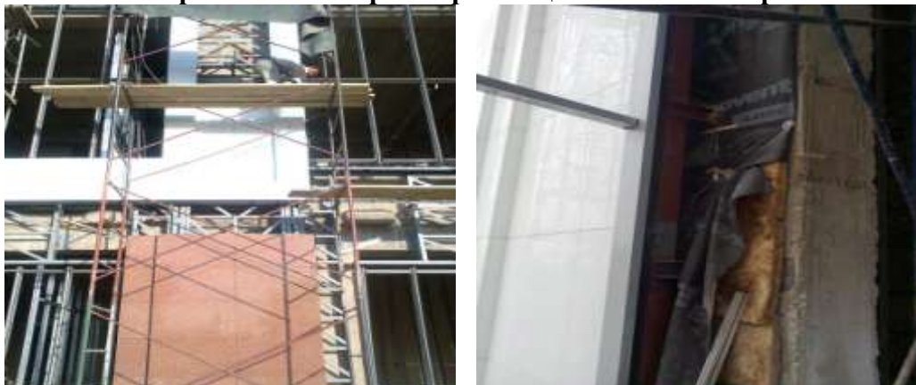
Фрагмент применения технологии «вентилируемого фасада»
