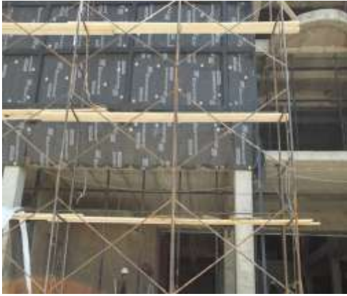
Фрагменты применения технологии вентилируемого фасада
