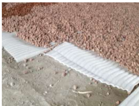
Теплоизоляция покрытия 1 этажа
