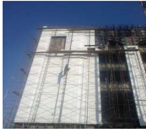
Фрагмент облицовки здания
