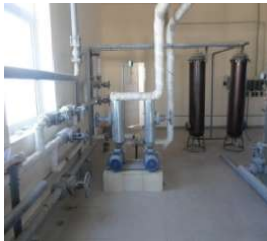
Система циркуляции отопления
